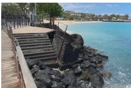
Édifier des murs protège momentanément les installations littorales, mais perturbe grandement les équilibres sédimentaires des récifs Les Roches Noires, 2023 et Boucan Canot, 2013
