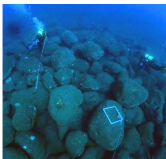
Les amas de galets seraient les structures artificielles les plus stables et les plus durables qui ont été testées à La Réunion (photos JS Phillipe - 2024)
