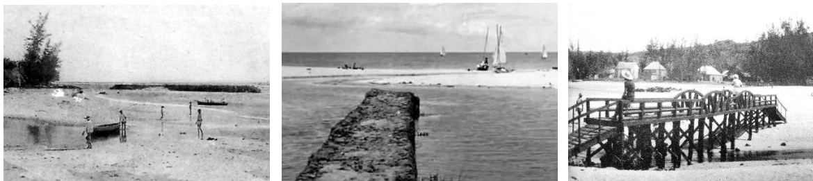
La jetée de Schneider aux Roches Noires construite en 1835 est encore bien visible en 1900 (photo 1) et en 1950 (photo 2). Elle servira de base pour un petit pont de bois (1936)
