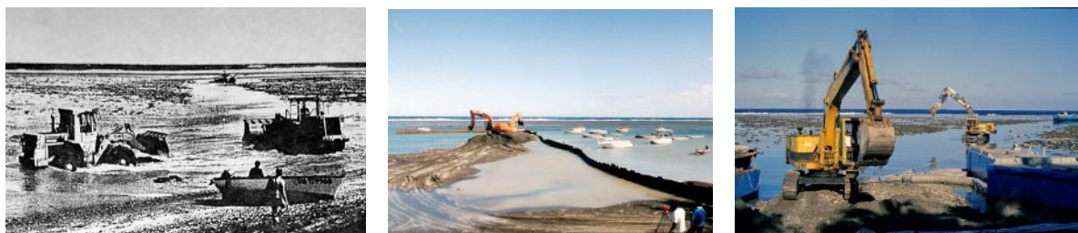
Les travaux sont parfois directement réalisés sur le récif corallien avec de gros moyens techniques – Étang-Salé, en 1983, 1999 et en 2011
