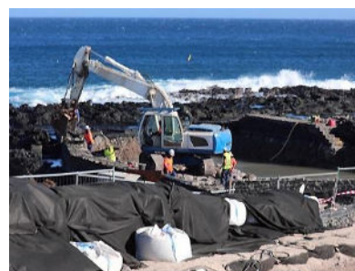
Édifier des murs protège momentanément les installations littorales, mais perturbe grandement les équilibres sédimentaires des récifs Les Roches Noires, 2023 et Boucan Canot, 2013
